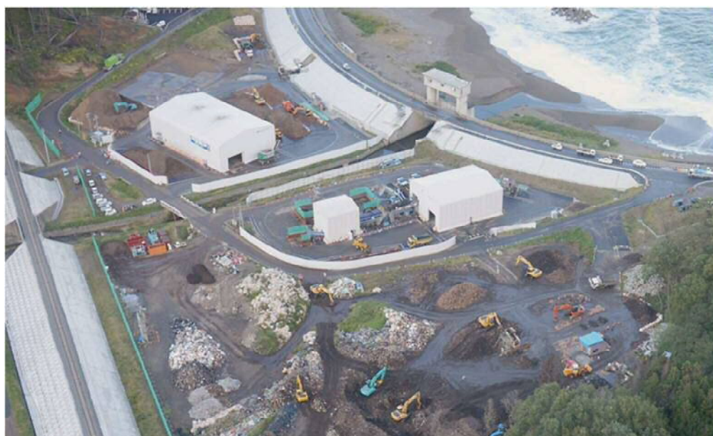
東日本大震災での二次仮置場の事例
