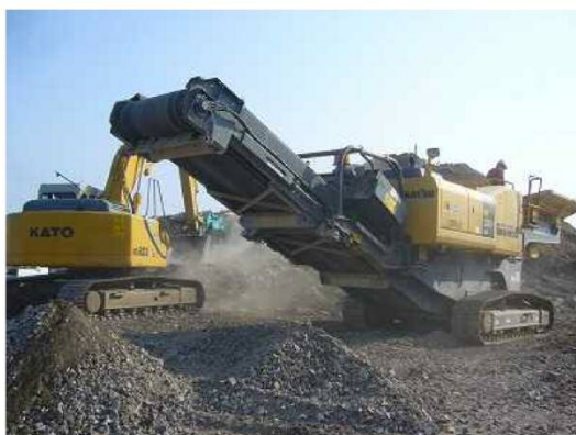
移動式コンクリート破碎機
