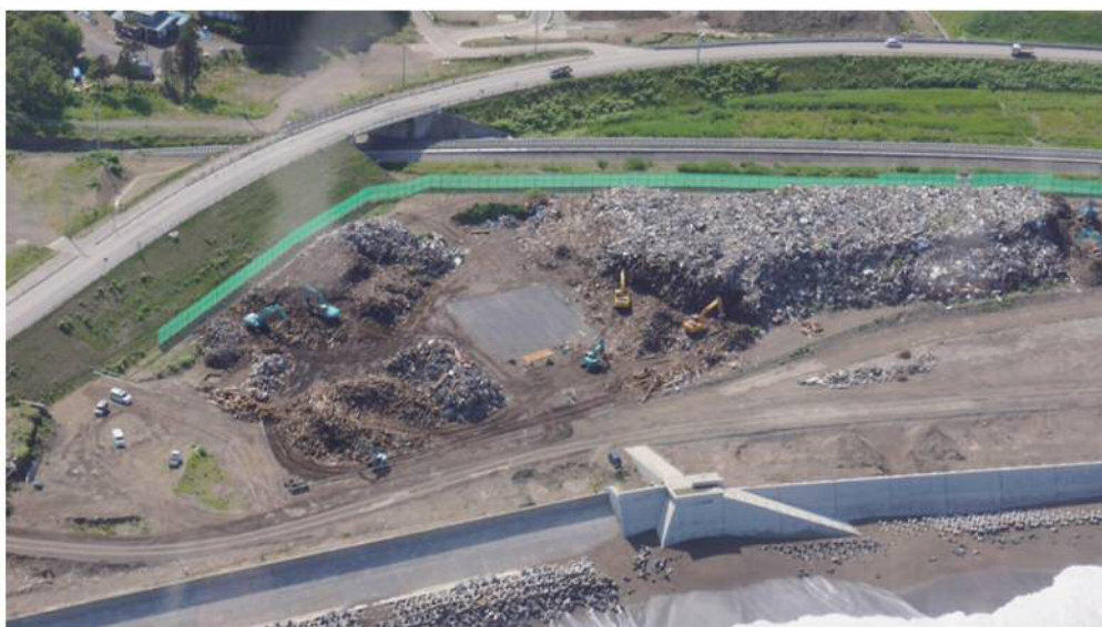
東日本大震災での一次仮置場の事例
