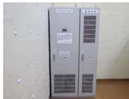
北地区コミュニティセンターに設置した太陽光発電設備（左）と蓄電池（右）
