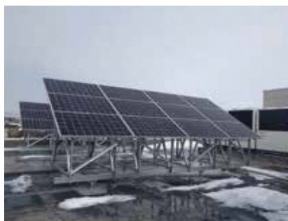
北地区コミュニティセンターに設置した太陽光発電設備（左）と蓄電池（右）
