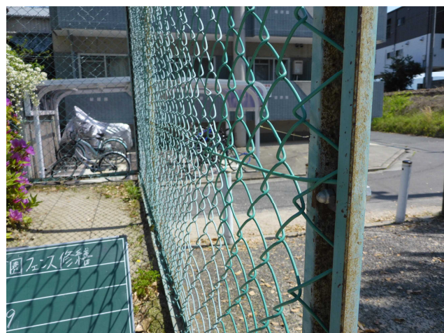
ボルト処置後
