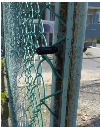
ボルト応急処置状況
