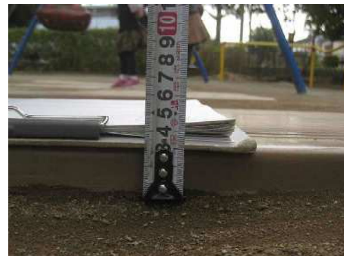
安全マット段差
