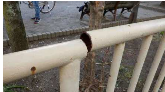
パイプ柵破断状況
