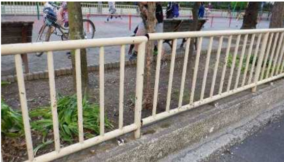
パイプ柵破断状況
