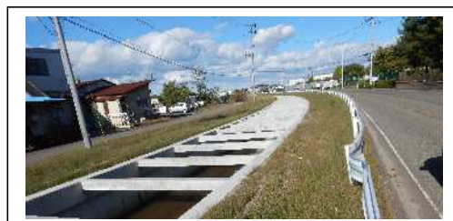
【江南区 山崎排水路】
