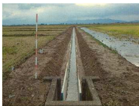
土水路から排水フリームへの更新
