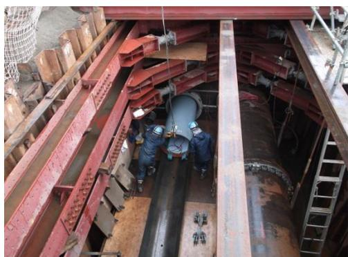
PIP(パイプインパイプ)工法による施工
