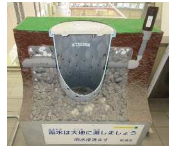
雨水浸透ます
