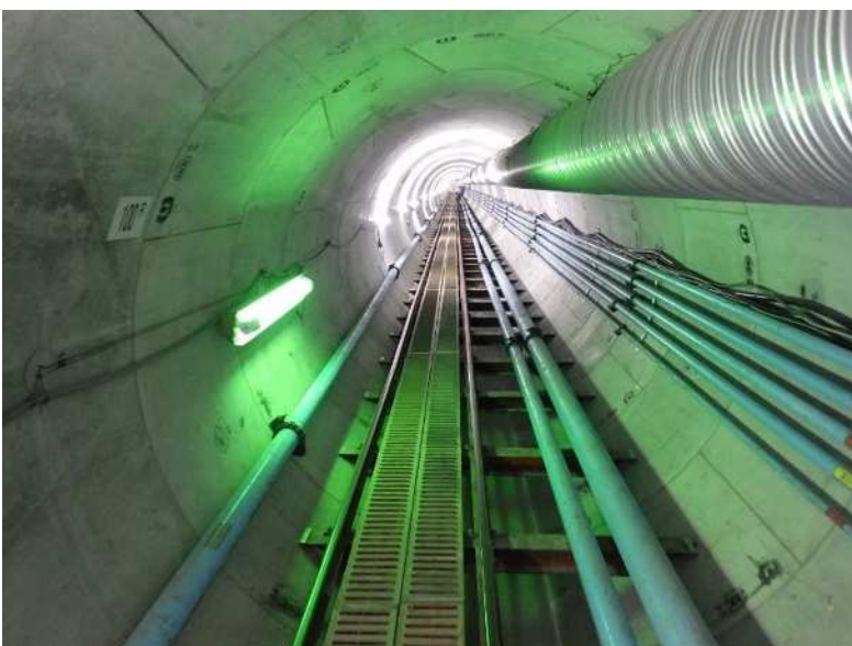
作業中のシールド管内
