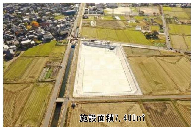
【横越雨水調整池】貯留量6,600 m ³
