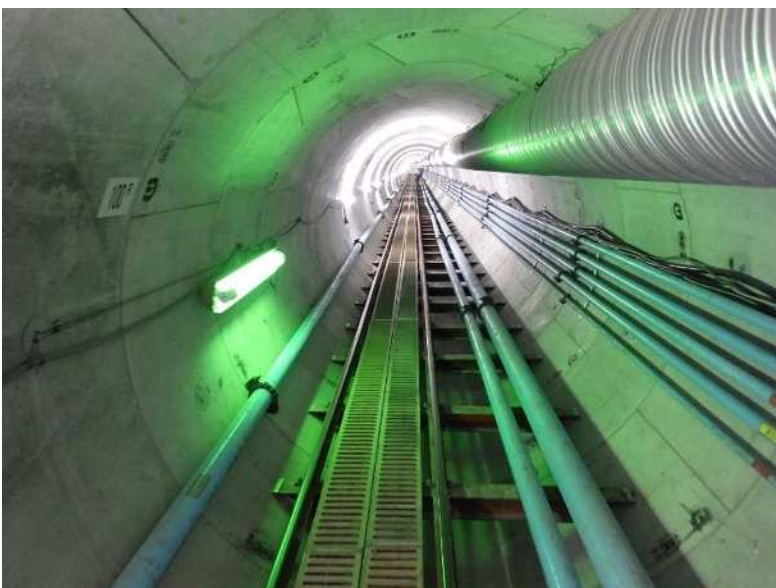
作業中のシールド管内
