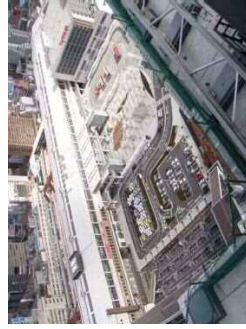
新潟駅南口広場 (平成21年度第1期工事終了)
