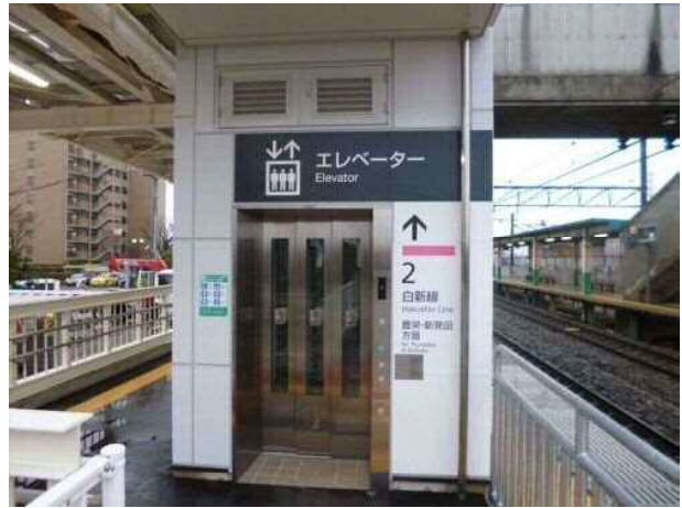
エレベーター設置（JR 東新潟駅）
