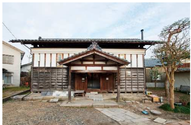
② 伏見家住宅外蔵 外観
