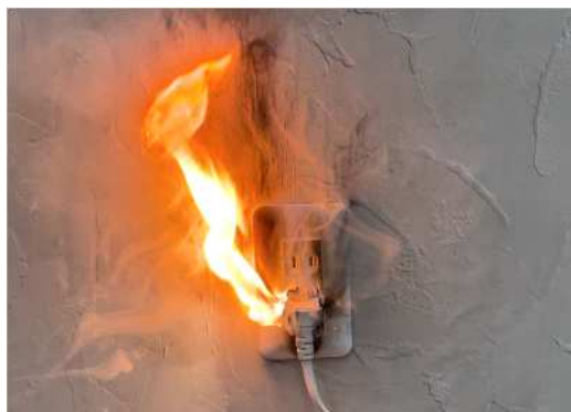
トラッキング現象
