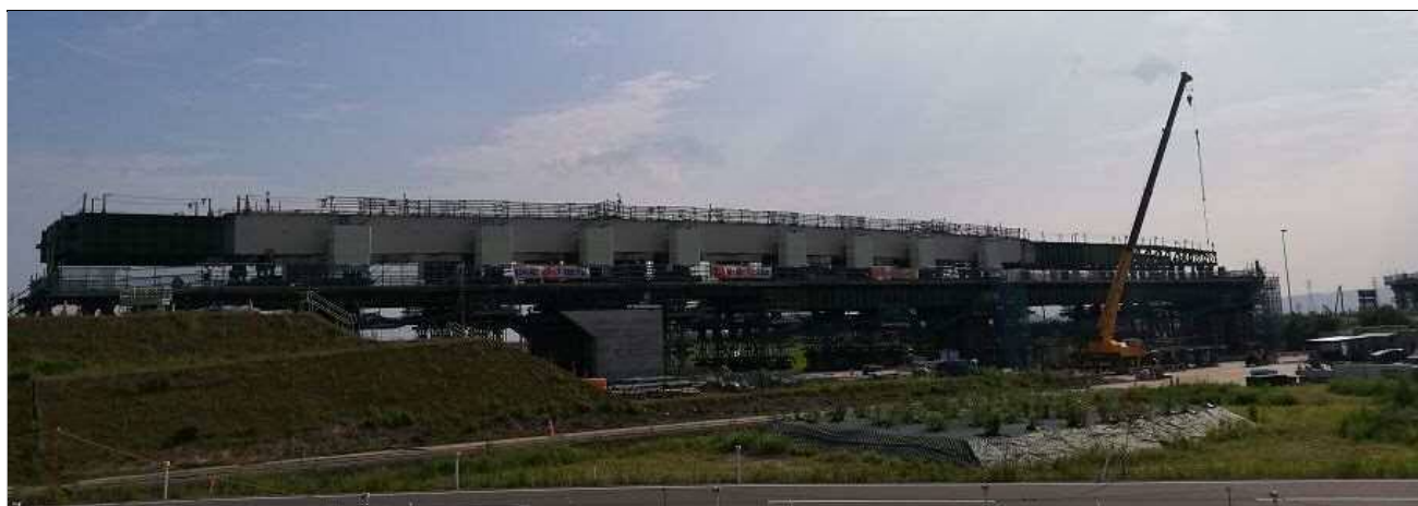
現場の状況 (令和2年8月1日現在)
