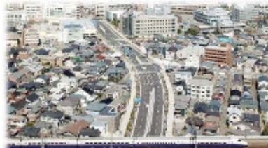
新潟烏屋野線の全面開通
