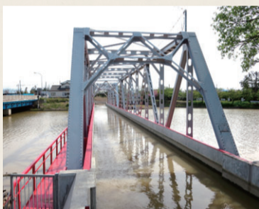
新川の上を通る西川水路橋
