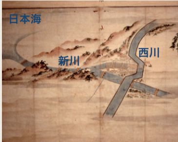
新川底樋伏せ替え工事図(個人蔵)
