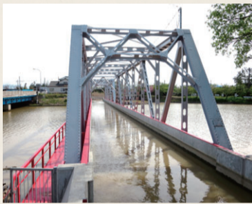
新川の上を通る西川水路橋
