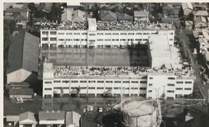
市内が浸水し学校の屋上に避難した人々 (旧入舟小学校所蔵写真)
