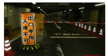
出庫口からの侵入防止の表示
