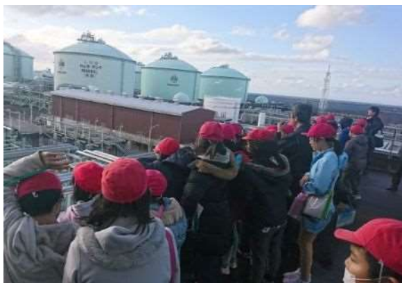
日本船主協会 出前授業 日本海エル・エヌ・ジー 新潟LNG基地見学会 （一般社団法人日本船主協会）
