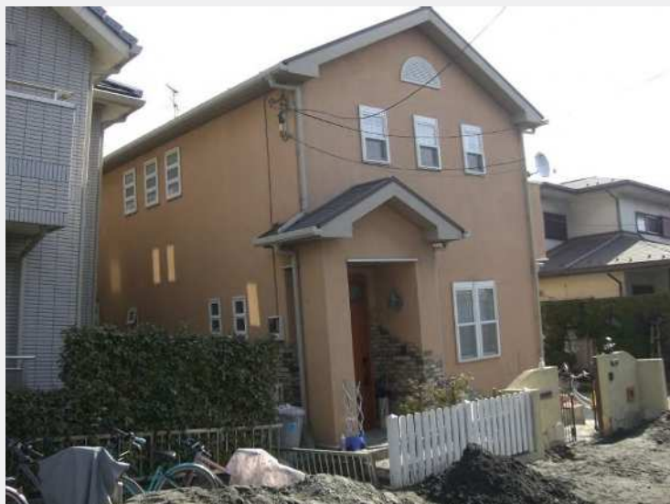
戸建住宅の傾斜
