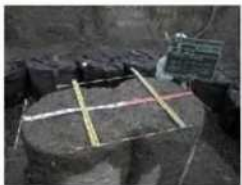
【機械攪拌工法（円形）】
