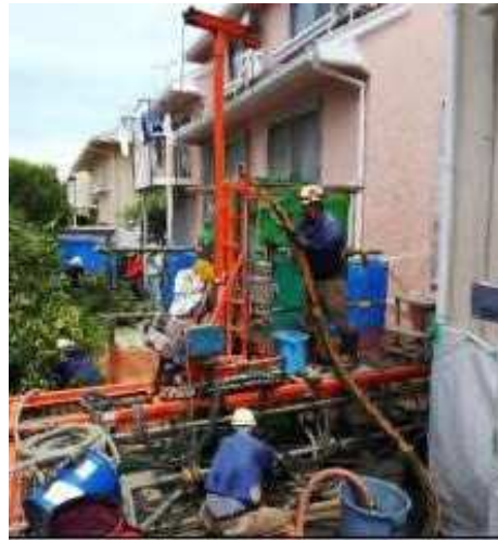
高圧噴射攪拌工法（宅地部）
