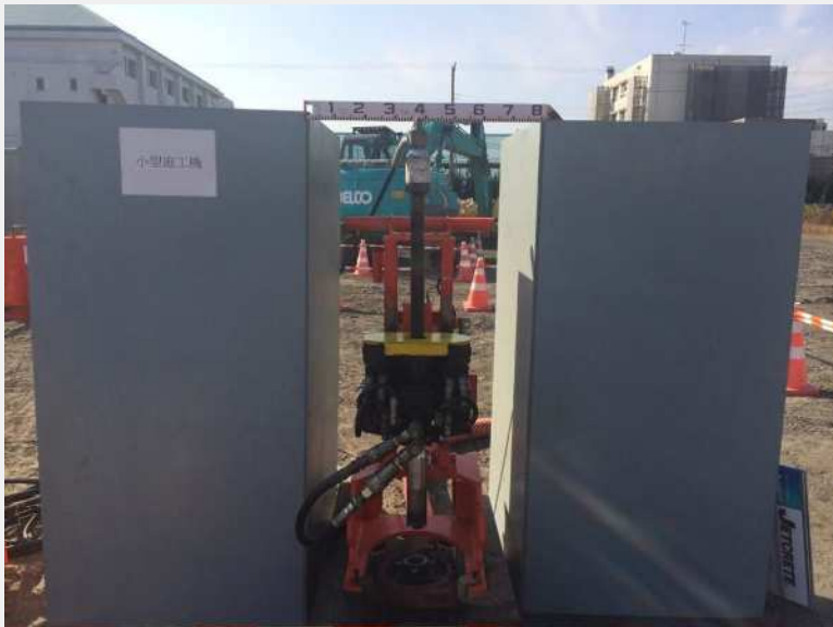
超小型高圧噴射攪拌工法（宅地部）
