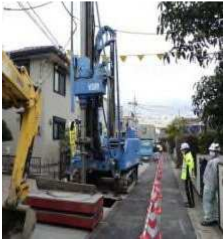
機械攪拌工法（道路部）
