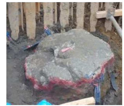
写真4 掘り起こされた改良体の杭頭 (No.1 Minyマル工法、円形)
