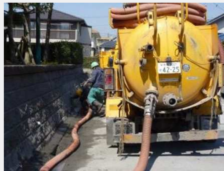
東京都下水道局による下水管内の土砂撤去作業
