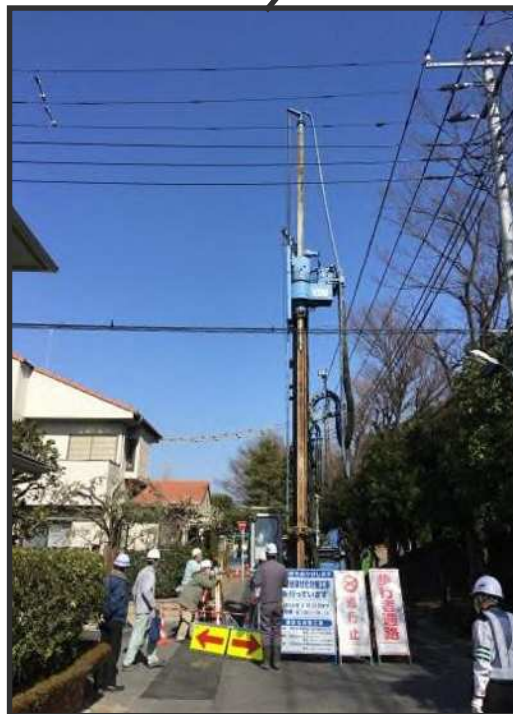
道路部改良工事（機械攪拌）
