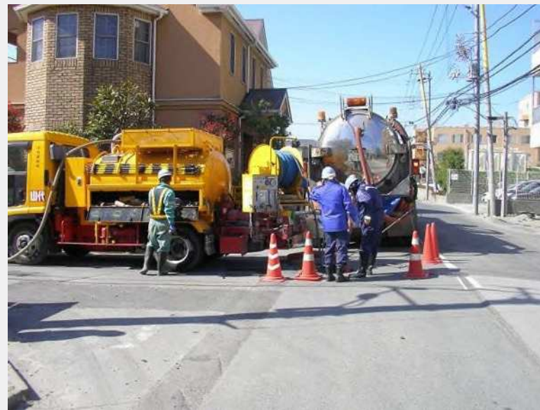
東京都下水道局による下水管内の土砂撤去作業
