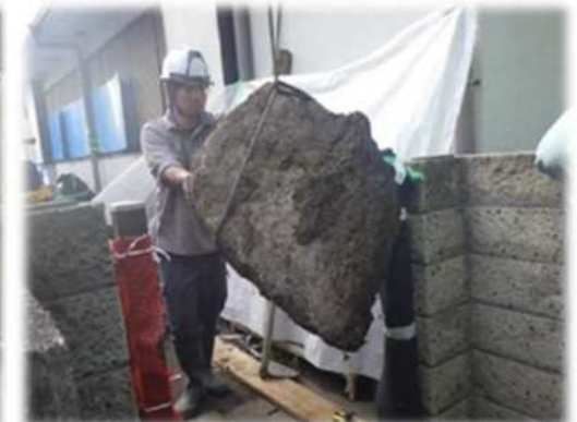
H30 東野地区 宅内地中埋設物
