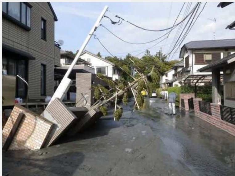
戸建住宅地区の液状化
