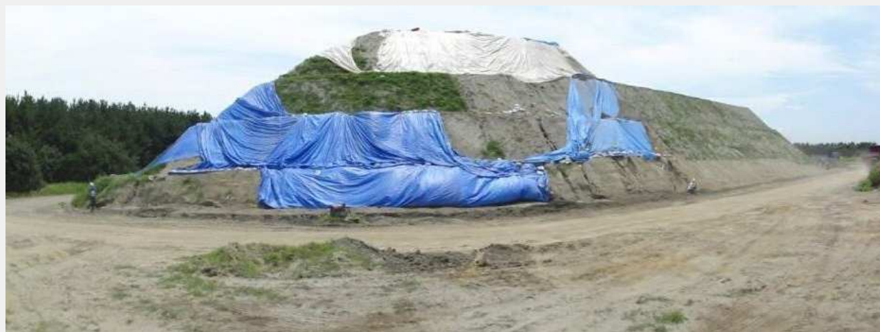
液状化により噴出した75,000m 3 の土砂
