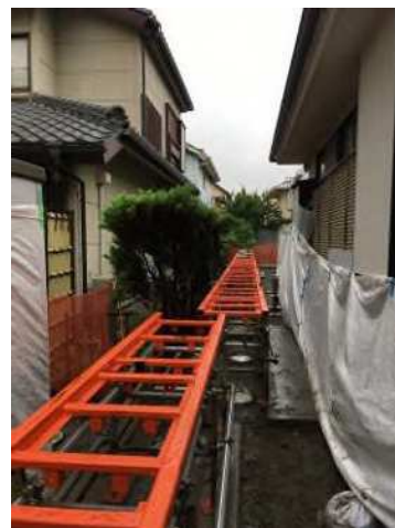
架台の設置（宅地部）
