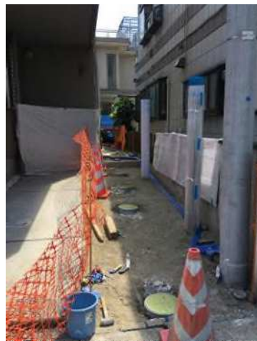
ガイド管の設置（宅地部）
