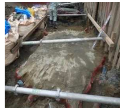
写真3 掘り起こされた改良体の杭頭 (No.4 Minyマル工法、楕円)
