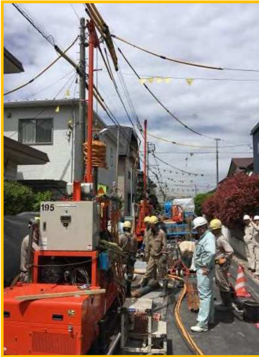
道路部改良工事（高圧噴射攪拌）
