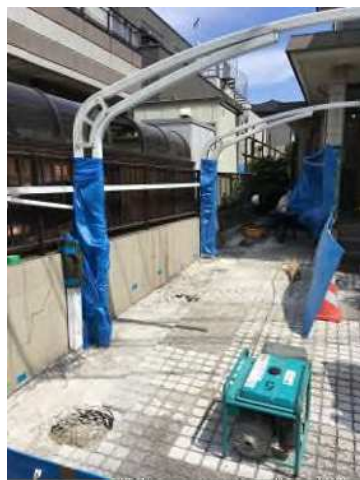
カーポート屋根の撤去移設
