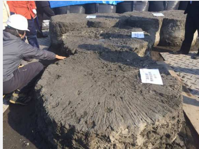
超小型高圧噴射攪拌工法（宅地部） 円形φ1500
