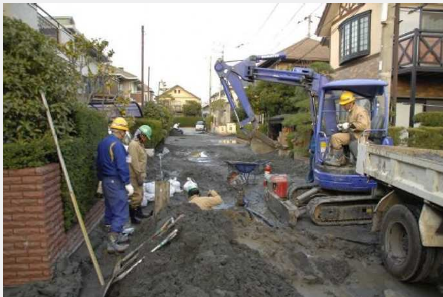
市建設協力会による下水管内の土砂撤去作業
