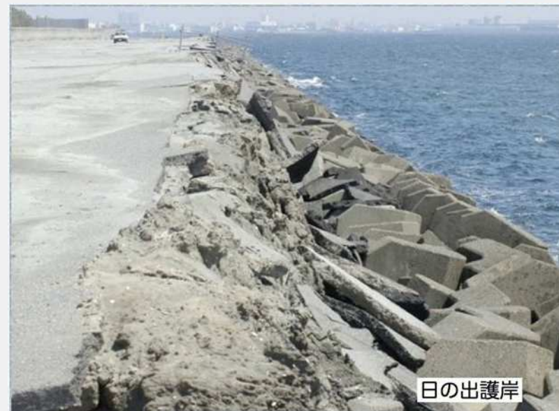
エプロン部分が3m迫り出した日の出護岸
