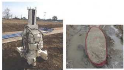
【小型高圧噴射攪拌工法(楕円形)】
