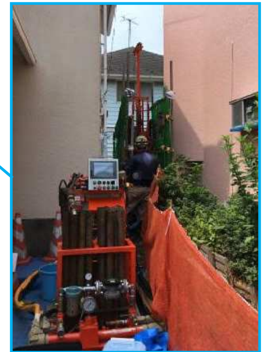
宅地部改良工事（高圧噴射攪拌）
