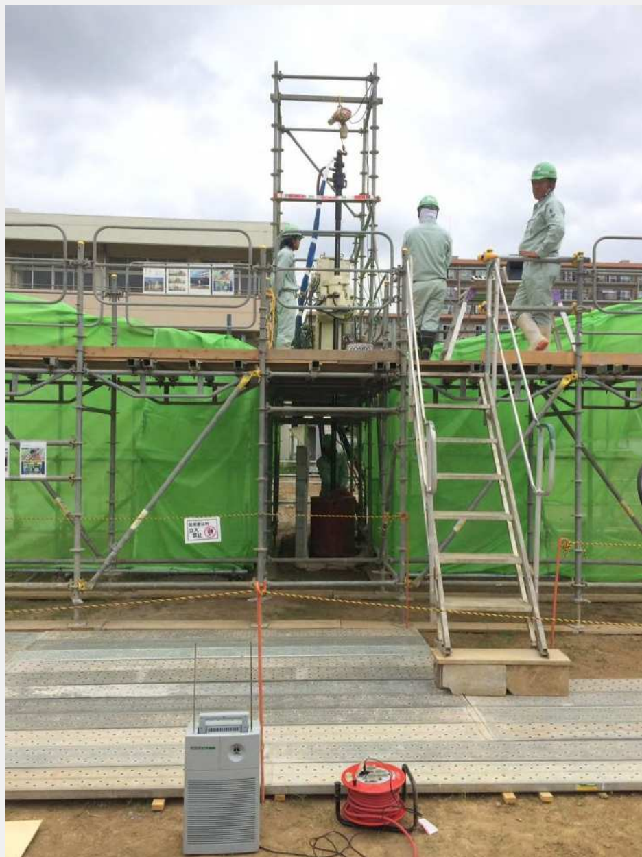
超小型高压喷射搅拌工法（宅地部）
