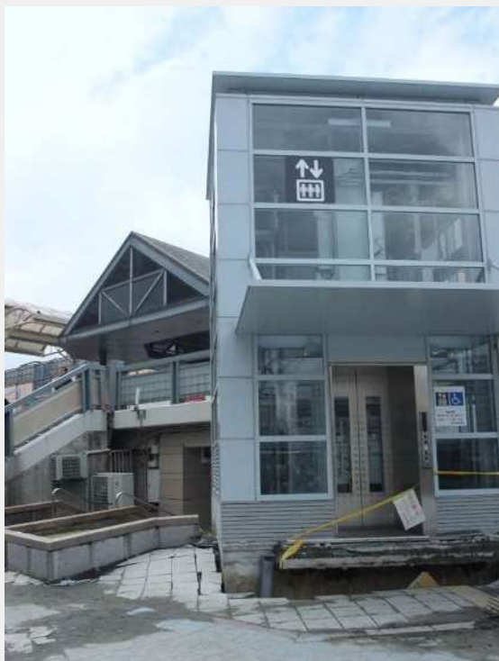
新浦安駅 駅前広場エレベーター
