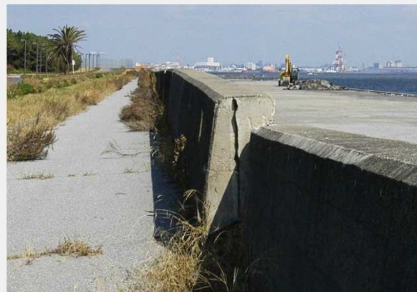
エプロン部分が3m迫り出した日の出護岸
