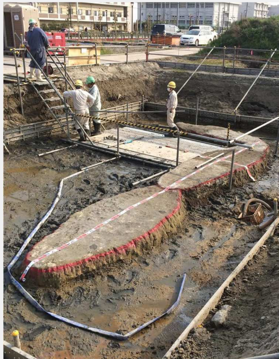
超小型高压喷射搅拌工法（道路・宅地部） 楕円形φ3600×1200
