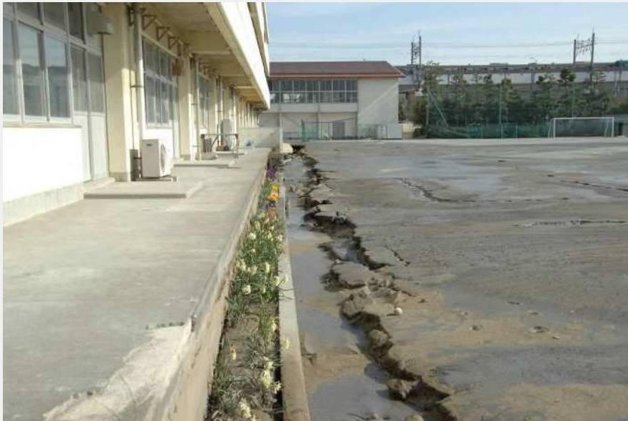
見明川中学校運動場の液状化
