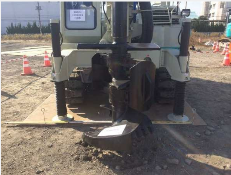
機械攪拌工法（道路部）
