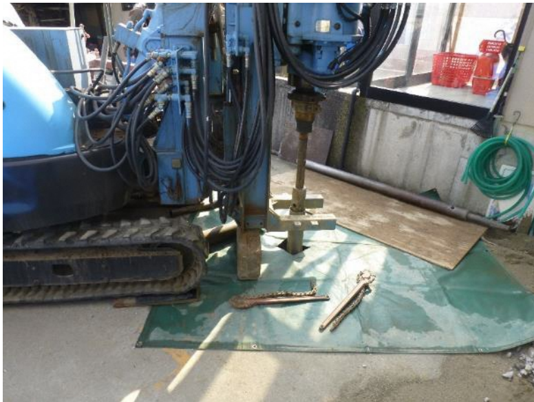
ボーリング調査(自走式機器)
