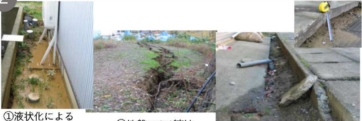
③地盤の沈下 15 cm
