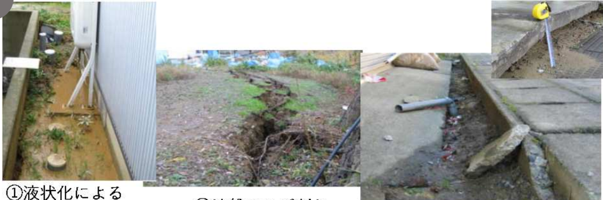
③地盤の沈下 15 c m
