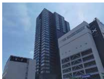
新潟駅南口第二地区
