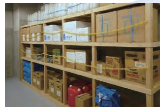
災害備蓄倉庫
