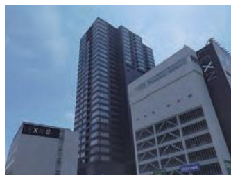
新潟駅南口第二地区
