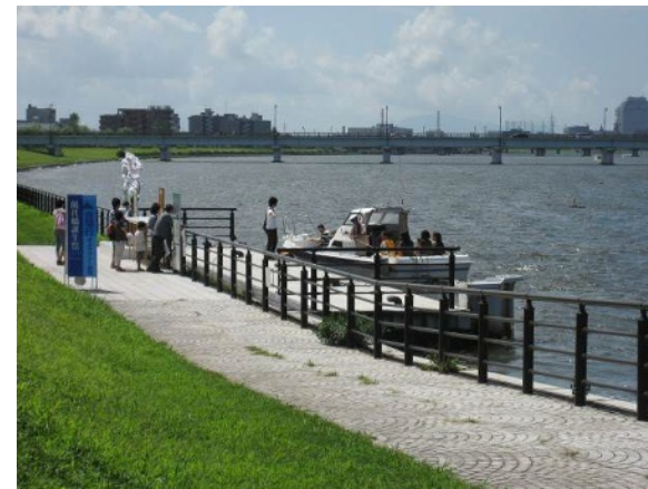
■転落防止柵の付替えにより、船着場上面を広場として一体的に利用できるようにする等の工夫を行う。
