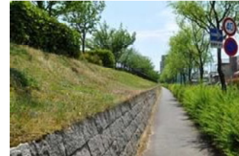
堤脚部(用語集⇒⑥)の道路幅を確保する腰積擁壁
