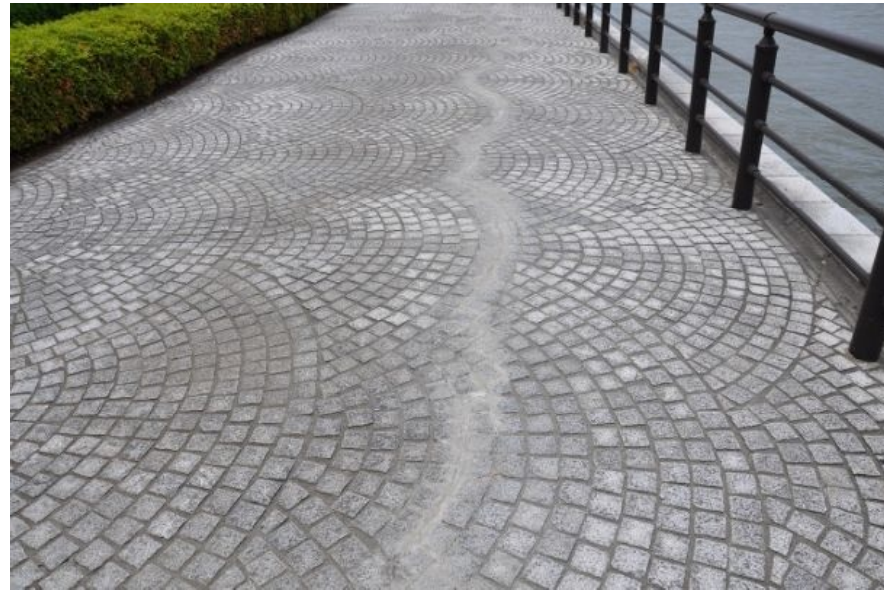
■萬代橋橋詰付近の自然石ピンコロ舗装
