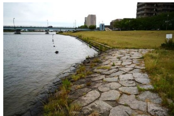
■階段護岸や緩勾配の石張り護岸が配置されており、水辺利用の拠点としてのポテンシャルが高い。 ■アクセススロープの整備等により利用性を高め、水辺イベントの拠点としての機能を高める
