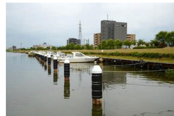
■矢板護岸前面が繋船場として利用されている。古タイヤの防舷材や錯綜するロープ等が、荒廃した雰囲気を生み出しやすい。
