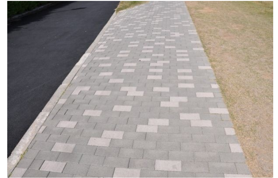
■萬代橋上流（右岸）の自然石張り舗装
