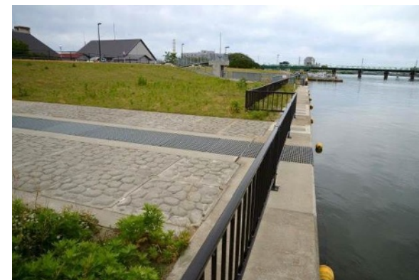
■屈折する樋門 (用語集⇒⑫) 放水口の転落防止柵 (右岸)。安全確保の機能が優先されデザインに十分配慮が行き届かないことが多い。
