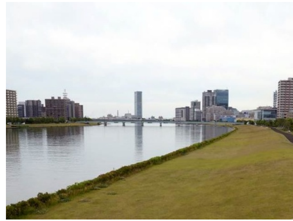
■生垣は多くの区間で採用されている。転落防止柵と比較すると、より自然で柔らかい雰囲気が演出できるが、植物の適切な維持管理が課題である。
