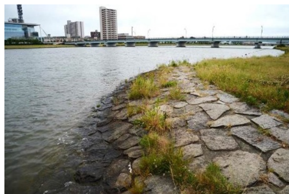
■自然石張の緩勾配護岸。肩の部分がラウンディングされており柔らかい印象となっている。階段ブロックに比較して構造物としての風格がある。
