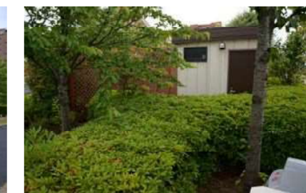
■トイレまわりは、外部からの見えに配慮して入念に植栽が行われている箇所があるが、植栽木が過度に成長すると、薄暗く死角も生じやすい。
