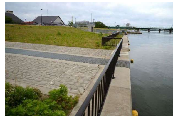
■屈折する樋門 (用語集⇒⑫) 放水口の転落防止柵 (右岸)。安全確保の機能が優先されデザインに十分配慮が行き届かないことが多い。
