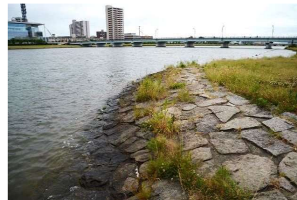
■自然石張りの緩勾配護岸。肩の部分がラウンディングされており柔らかい印象となっている。階段ブロックに比較して構造物としての風格がある。
