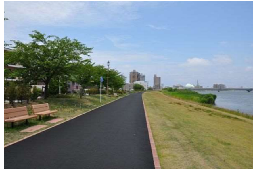
■堤防天端のゴムチップ舗装（左岸 7.6km 付近）
