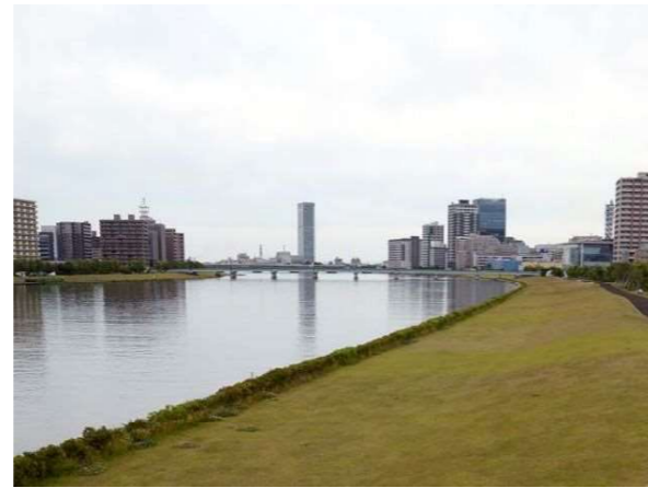
■生垣は多くの区間で採用されている。転落防止柵と比較すると、より自然で柔らかい雰囲気が演出できるが、植物の適切な維持管理が課題である。
