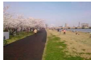
ラウンディングにより自然的な印象となっている堤防法肩部(用語集⇒⑦)
