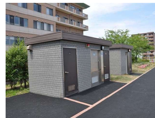
■既存のユニット式トイレ 新規及び更新整備では、事例のようなシンプルで控え目なデザインに統一する。
