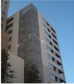
▲ 屋外階段の周囲にルーバーを設け、壁面位置を揃えることにより、全体としてまとまりのある外観となるよう配慮しています。 (中央区)
