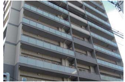
▲ バルコニー部分に建物本体と同一の外壁材や半透明の材料を使用することにより、内部機能が外部から見えないよう配慮しています。 (中央区)
