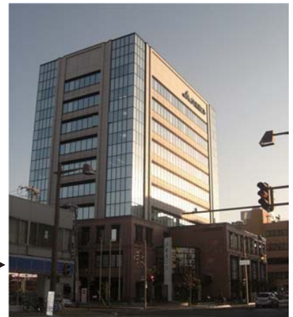
▶ 上層階の壁面位置の後退により、通りへの圧迫感やボリューム感の軽減を図っています。 (中央区)
