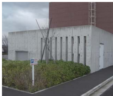
▲ 設備類の周囲を工作物で囲い、目隠しを施しています。 (中央区)
