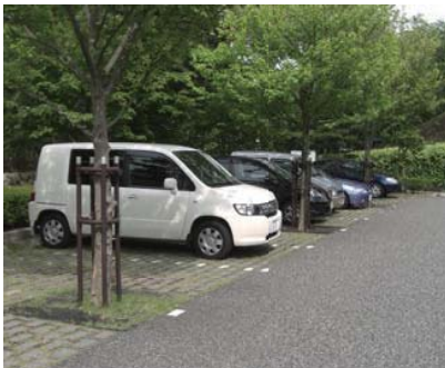
▲ 駐車場の敷地内において、緑化ブロック舗装や中木の植栽を行い、殺風景な印象とならないよう配慮しています。 (中央区)
