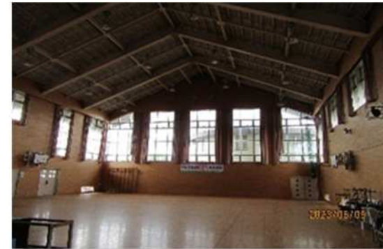
旧潟東西小学校体育館
