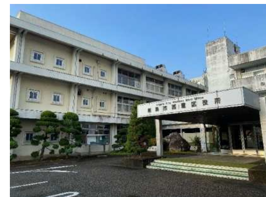
西蒲区役所庁舎外観
